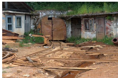
Evacuarea apelor reziduale din mină
