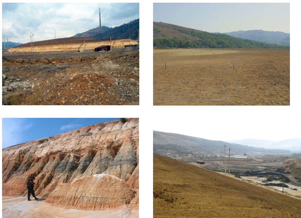
Fig. 3.26 – Iazul de decantare Zlatna – aspecte generale
