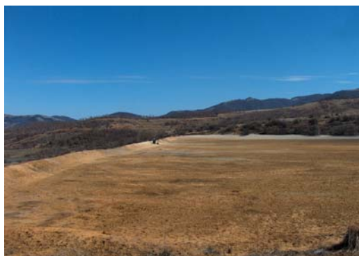
Fig. 3.39 – Topul iazului de decantare de la Valea Mică
