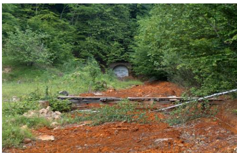
Evacuarea apelor reziduale din mină
